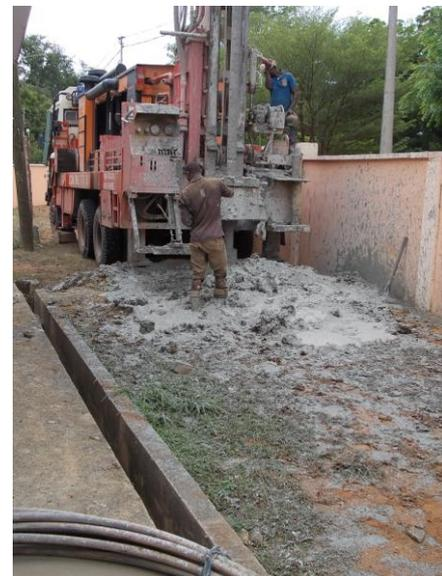
Bildquelle: Mp-tec GmbH & Co. KG, Brunnenbohrarbeiten für die mp-tec „solarpumpe“
