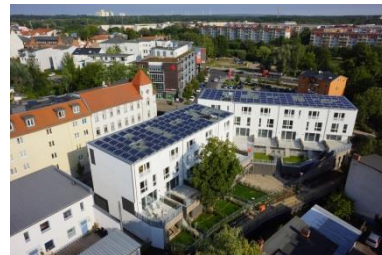
Luftaufnahme der Flachdachanlage auf den beiden Dächern der Michaelisgärten
